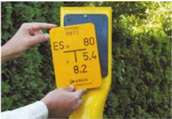
Aufschnappen des FP-Hinweisschildes Snapping in the FP indicator sign
